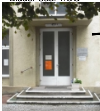
5 Eingang Haus 47/I • Paul-Gerhardt-Saal EG • Kirchhofsbüro 1.OG • Kirchenmusik 1.OG • Blauer Saal 1.OG
