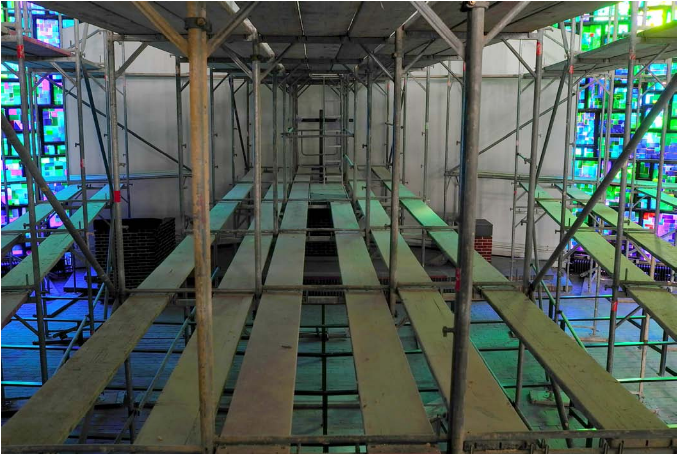
Der eingerüstete Kirchenraum - Foto: Wolfgang Blech
